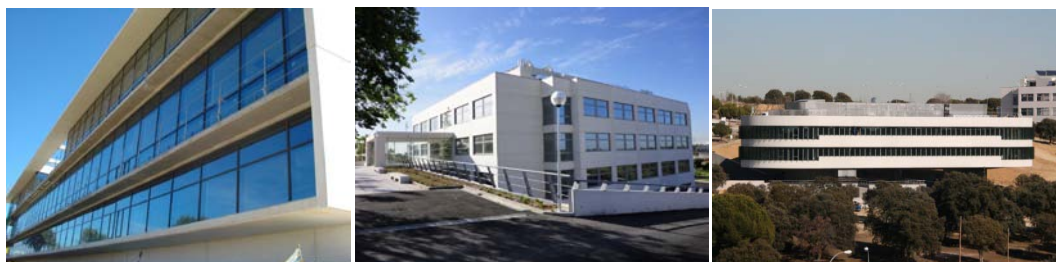
Figura 2. Imágenes de los edificios que albergan el CTB y el COM, el IMDEA Software y el CAIT
